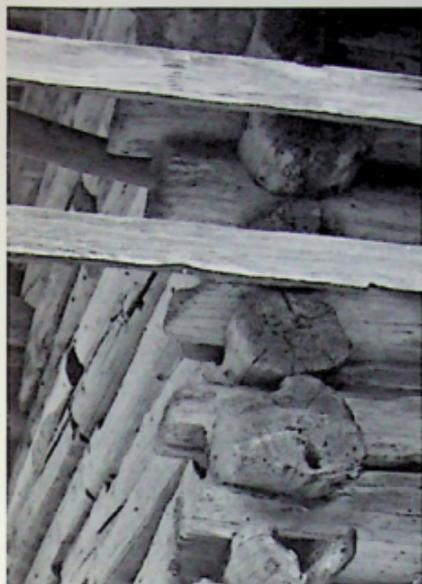
Fig. 5 - Incastro di tronchi non squadrati agli angoli del block-bau.
